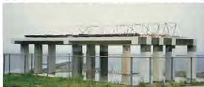
写真1 実構造物の設置状況
