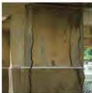
写真2 柱Aの外観
