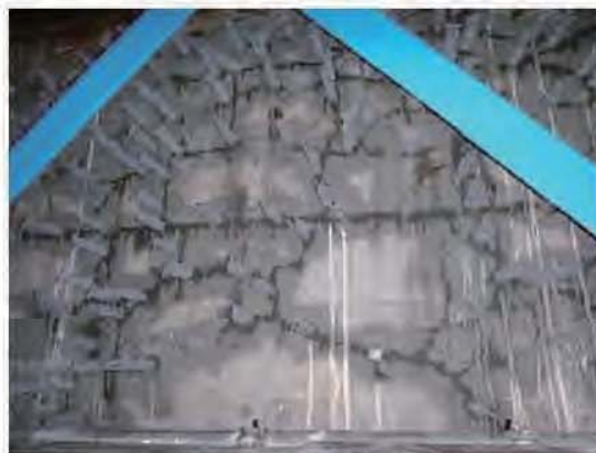
図-4 ひび割れ注入工
