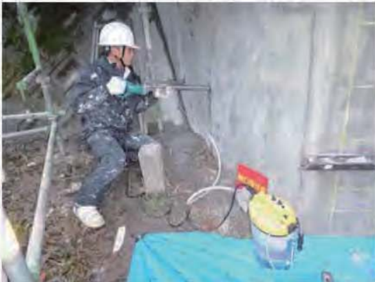
図-7 圧入孔削孔工(φ10mm)
