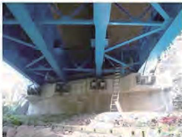
図-1 湯村大橋 A1 橋台の外観
