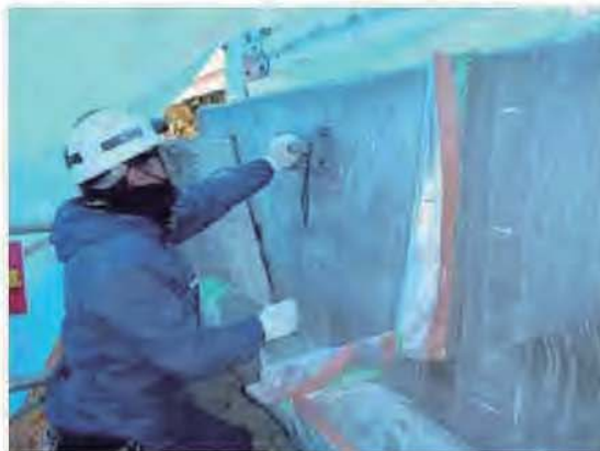
図-5 鉄筋探査工
