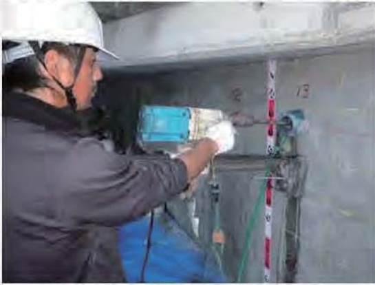
図-6 圧入孔削孔工(φ20mm)
