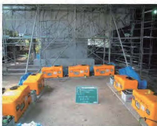
写真-2 海田高架橋施工状況
