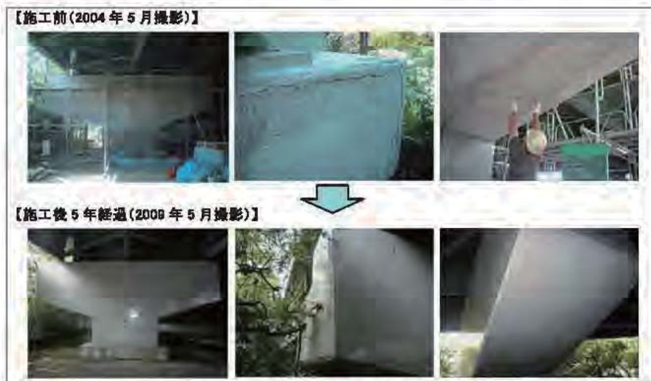
図-3 K高架橋橋脚 施工前状況と施工後5年経過時の状況
