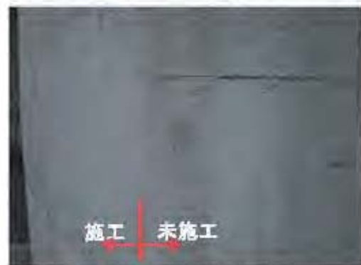
図-6 施工境界付近の状況
