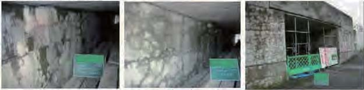
【施工前(2005年8月撮影)】
