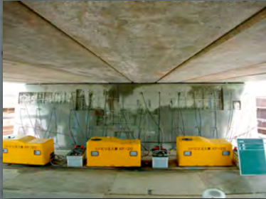
内部圧入工 (ASRリチウム工法)
