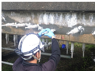
③亜硝酸リチウム先行注入
