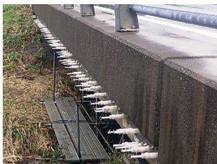
④超微粒子セメント本注入
