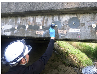
②ひび割れシール
